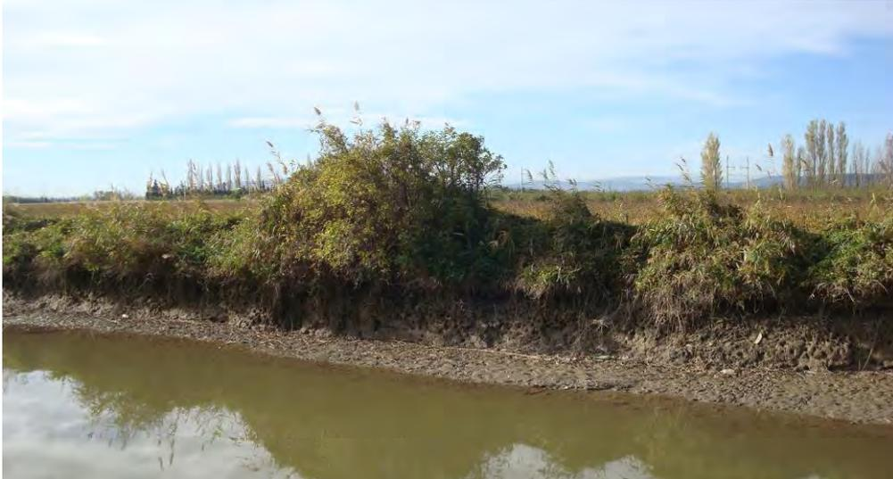
Dégâts occasionnés par les ragondins et les écrevisses de Louisiane aux berges du Canal de la Robine (bief de Mandirac) apparaissant lors d'une mise en chômage.
